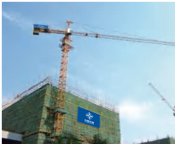
建筑楼面示例
